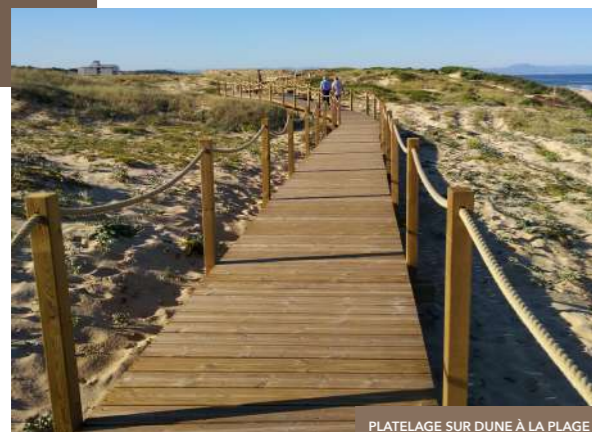
PLATELAGE SUR DUNE À LA PLAGE DU PENON Réalisation : COPLAND Lieu : Seignosse 40510 © Rodrigue ESPADA
